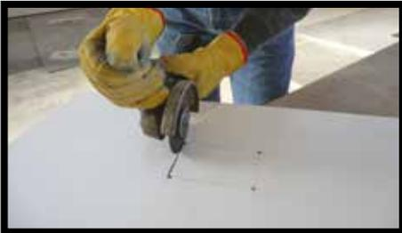
**Fig.11** - Para la realización de cortes internos y en "L" se recomienda redondear los vértices de la apertura utilizando puntas con un radio de al menos 5 mm para reducir el riesgo de roturas. Después realice el corte con discos diamantados tomando la precaución de detener el avance una vez alcanzado el orificio que se realizó anteriormente. Para la realización de la perforación y el corte con discos diamantados siga las indicaciones mencionadas anteriormente.
