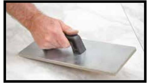
**Fig.30** - Tras la colocación de la lámina es necesario adherir la cola en todos los puntos para evitar la formación de vacíos y burbujas de aire. Para ello se debe utilizar un fratás de goma (por ejemplo **Raimondi** "142G").
