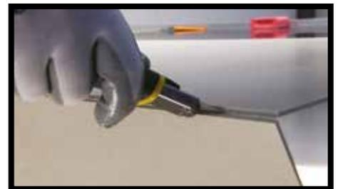
**Fig.4** - En el caso de KERLITE 3PLUS y KERLITE 5PLUS, una vez se haya realizado la incisión en la parte cerámica y la placa se haya separado, el corte se completará cortando la fibra de vidrio con un cúter convencional.
