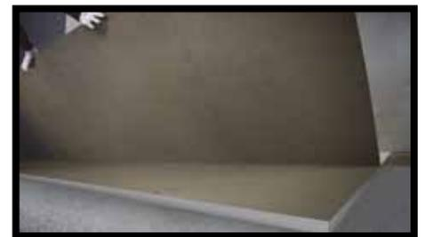
**Fig.32** - Se deben colocar apoyando uno de los lados largos para luego acompañarlas sobre el soporte.
