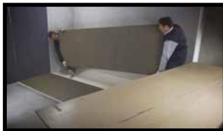
**Fig.31** - Desplazar las láminas manteniéndolas primero en posición vertical, sosteniéndolas por el borde superior. Muévase manteniendo las láminas rectilíneas con la ayuda de otra persona.
