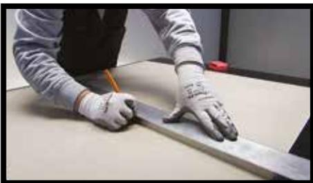
**Fig.2** - Para conseguir una incisión lo más rectilínea posible se puede utilizar un taquímetro de aluminio como los que emplean los albañiles.
