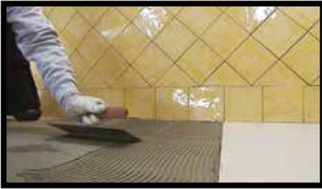
**Fig.28** - Esta técnica se indica **exclusivamente** para los adhesivos que en la ficha de su productor correspondiente expresan "colocación con embadurnado simple". Extender el adhesivo sobre la totalidad de la superficie de soporte. Siga las indicaciones del productor del adhesivo con respecto al tipo de espátula y la modalidad de extensión.
