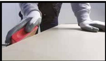
**Fig.12** - Los acabados de los cantos se pueden realizar a mano empleando esponjas diamantadas o papel de lija. Con una pasada ligera sobre el lateral de la lámina se puede obtener un efecto desigual o si se prefiere se obtendrá un efecto de bisel con más pasadas.
