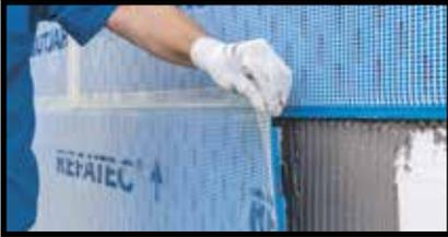
Extensión de la cámara CeraVent de arriba a abajo y de manera escalonada
